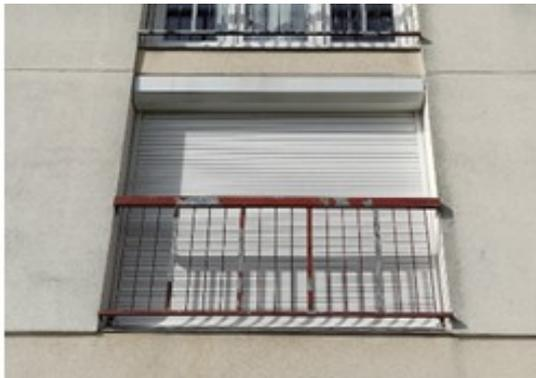
Corrosion sur l'ensemble des garde-corps
